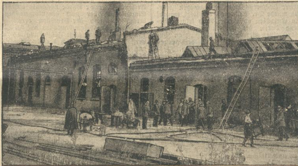
Das schwer beschädigte Gebäude der Filmverwertungsfabrik in Berlin-Spandau, in der aus ungetrübter Urjaube eine Filmrolle in Brand geriet und eine fürchterliche Explosion anrichtete.
