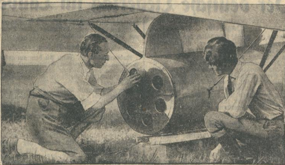
Das Einsetzen der Startrakete in das Segelflugzeug.
