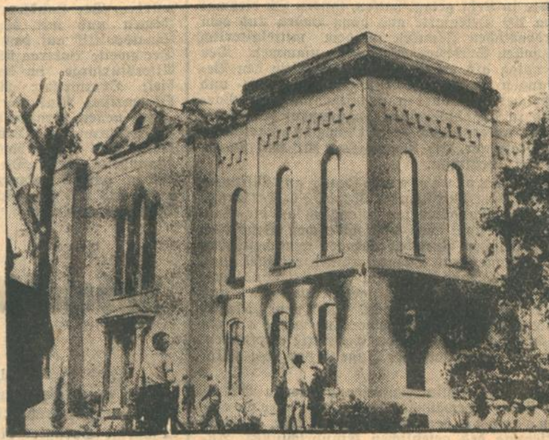
Das Gerichtsgebäude von Sherman nach dem Brand.
