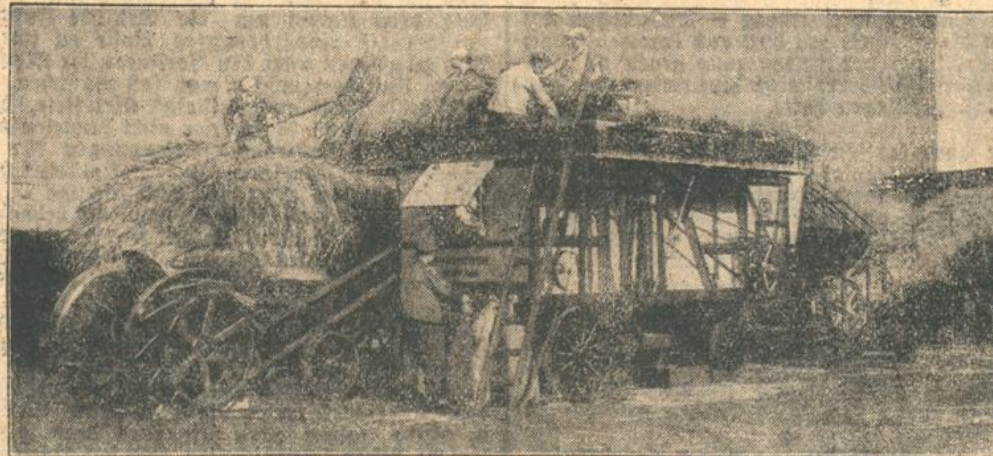
Ein Trecker mit Riemenscheibe betreibt eine Dreschmaschine.
