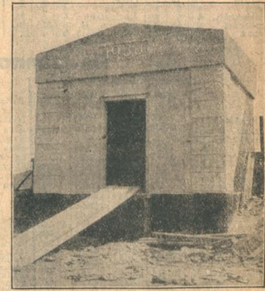
Der neue Hochbehälter für die Wasserversorgung Brettens.
