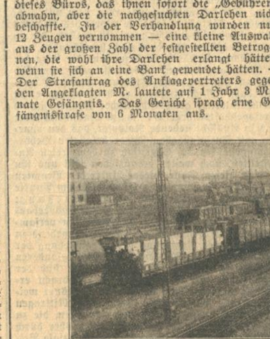
Der Karlsruher Rangierbahnhof ist nicht so modern, bewältigt aber immer noch ein stattliches Arbeitspensum.
