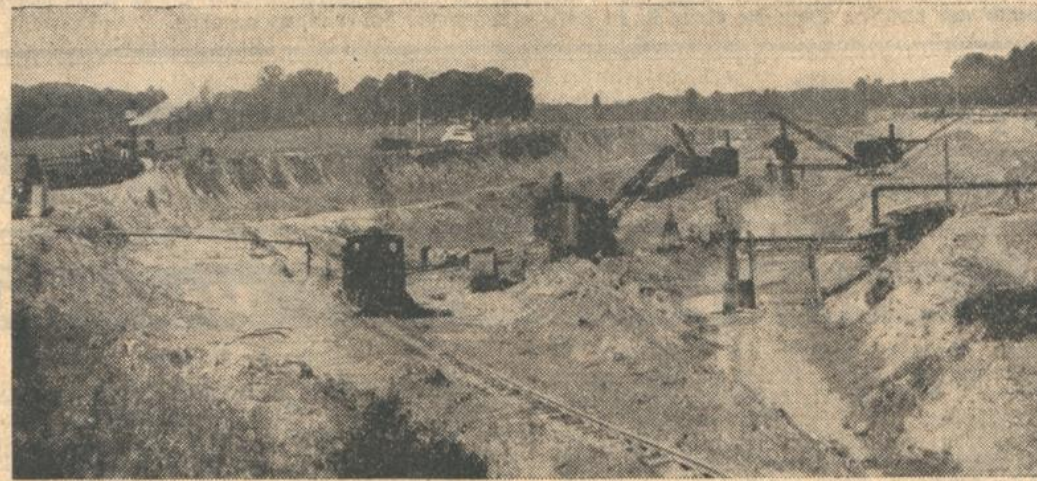
Die Bagger arbeiten am Stichkanal.
