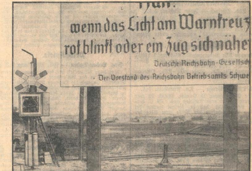
Blick auf einen der neuen schrankenlosen Bahnübergänge, bei denen das Nahen eines Zuges durch Aufleuchten einer Signallampe angezeigt wird. Statt der Bahnschranken werden jetzt Versuche mit neuartigen Signallampen an Bahnübergängen gemacht, die beim Nahen eines Zuges aufleuchten.
