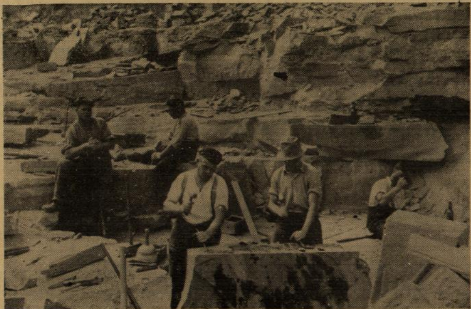
Werk Ittersbach: Bearbeitung von Werksteinen
