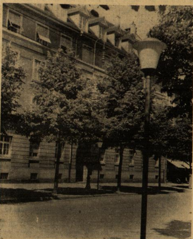
Probeklampen leuchten zurzeit in der südlichen Bahnhofstraße
