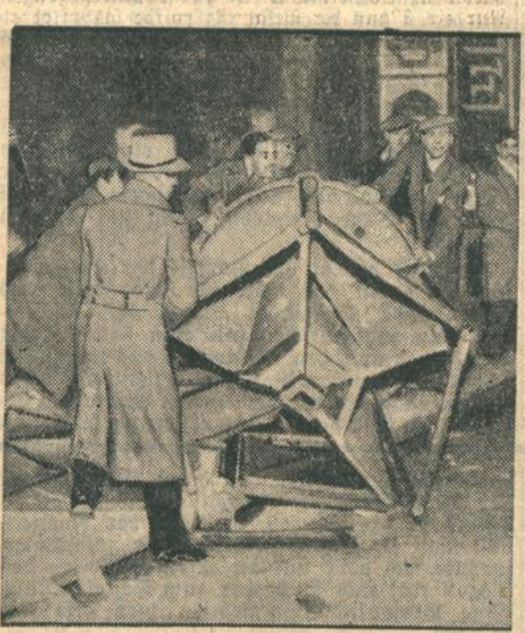
Ein großer Gasandelaber, der am Platz de la Concorde (Platz der Eintracht!) ungeworfen wurde.
