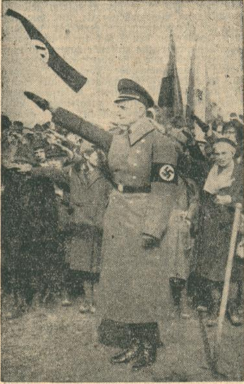
Reichsstatthalter Robert Wagner beim ersten Spatenstich zum Niedkanal.
