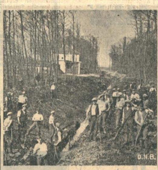
An der Hauptbaustelle Bahnhof Rot-Malsch
