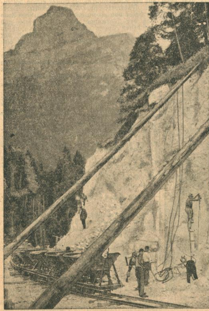
Die deutsche Queralpenstraße Einbau-Berichtsgebden Bohrungsarbeiten in einem Felsental des Berichtsgebden Landes.
