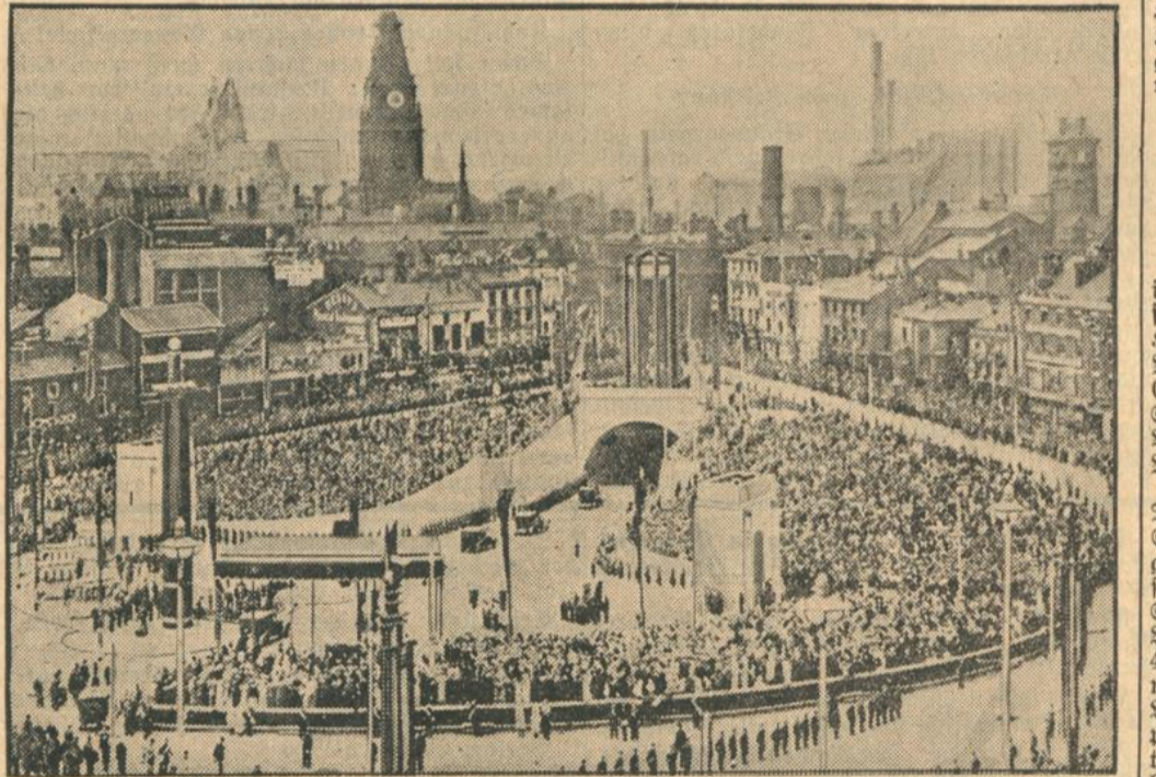
Ein Ueberblicksbild von der Einweihungsfeierlichkeit, mit der der Unterwassertunnel zwischen Liverpool und Birkenhead am 18. Juli in Gegenwart von 150.000 Menschen durch den König von England seiner Bestimmung übergeben wurde. Der Tunnel ist 1/2 Kilometer lang und 14 Meter breit. Auf seinen vier Fahrwegen können täglich 4200 Kraftfahrzeuge passieren. Der Bau des Tunnels beanspruchte acht Jahre. — Die Aufnahme hat den Augenblick festgehalten, in dem das enalliche Koniaspaar in den Tunnel einfährt und ihn damit eröffnet.
