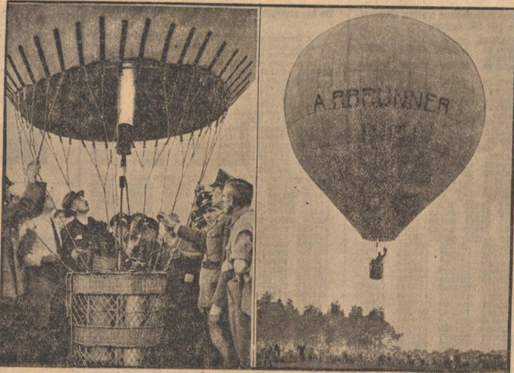
Der in Deutschland lebende Oesterreicher Brunner hat, wie gemeldet, einen Heißluftballon konstruiert, mit dem er jetzt bei Gerswalde aufsteigen ist. Der Ballon erhält seinen Auftrieb durch Petroleum, die durch eine mit Kohlen geladene Gebläseanlage erzeugt wird. Der Ballon kann solange in der Luft bleiben, wie Brennstoff für die Gebläseanlage vorhanden ist. Die Hülle besteht aus feuerfest imprägniertem Baumwollstoff. Bei seinem ersten Aufstieg erreichte der Ballon 800, beim zweiten 1500 Meter Höhe. Die Aufnahmen zeigen (links) den Erfinder beim Überprüfen der Gebläseanlage und (rechts) den ersten Start dieser modernen Montgolfiere.
