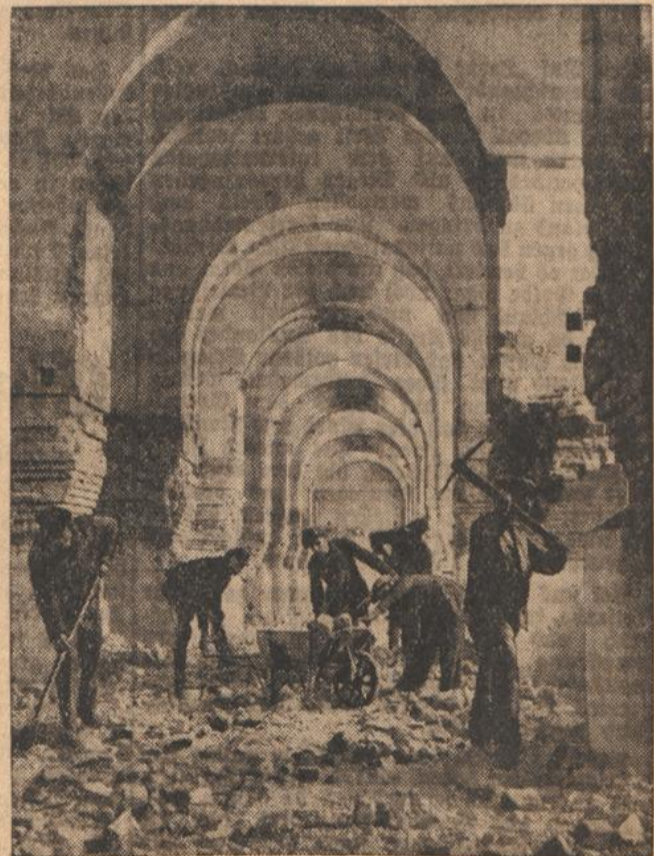
Die Kasematten des alten Forts Biehler bei Mainz werden zur Zeit von Arbeitslosen abgebrochen, denen das hiermit gewonnene Baumaterial für die Errichtung von Steblunnsdäusern kostenlos zur Verfügung gestellt wird.
