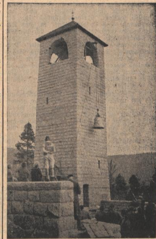
Das Aufziehen der Glocke in den Glockenturm im Turm des Ehrenmals
