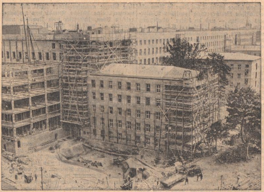
Der heutige Stand der Bauarbeiten am Reichsluftfahrtministerium
