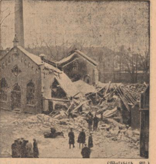
Die Trümmer der Bronzeabfabrik Remmühle bei Altenburg in der Nähe von Nürnberg, wo sich, wie gemeldet, eine soltaenschwere Explosion ereignete, der drei Arbeiter zum Opfer fielen
