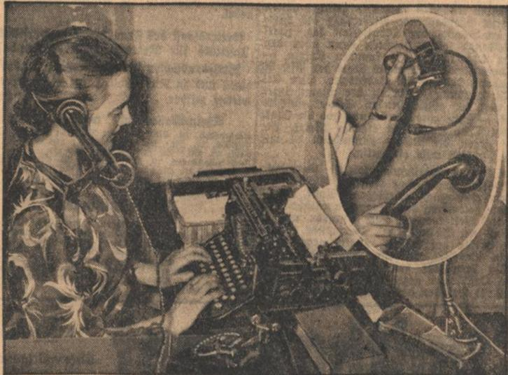
Das Telefon für Dauersprecher (Stressphoto, W.) Eine Neueruna auf dem Gebiete der Telefona hat der Berliner Konstrukteur Bildbrand geschaffen. Er hat einen Galtex für den Telephonörer konstruiert, der mit Beiläufigkeit anubringen ist und kaum einen Druck ausübt. Die Sontophone erhält ihr Diktat durchs Telefon und schreibt es direkt in die Maschine. Im Ausschnitt der neuartige Galtex
