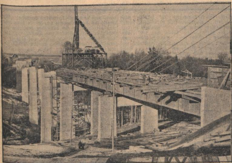
Neuer gewaltiger Brückenbau der Reichsautobahn (Illustriert, M.) Ein weiteres gewaltiges Bauwerk im Zuge der Reichsautobahn zwischen Landesgrenze ist ein Talübergang zwischen Giesdorf und Trellendorf bei Traunklein. Die Stahlbrücke überbrückt hier in 308 Meter Länge die 42 Meter tiefliegende Talsohle, 6 Doppelturm Pfeiler mit Stahlüberbau tragen das fünfjährige Fahrbahn.
