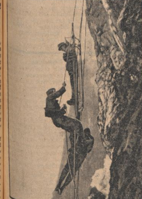
Absteigen mit einem „Verteilen“ Ein interessanter Schnappschuß von der Hebung einer deutschen Sanitätsstaffel auf dem Kreuzschiff am Kreuzschiff. Der Transport eines „Schwerverletzten“ über eine unterirdische Wand mittels einer aus Stieren zusammengesetzten provisorischen Tragbahn.
