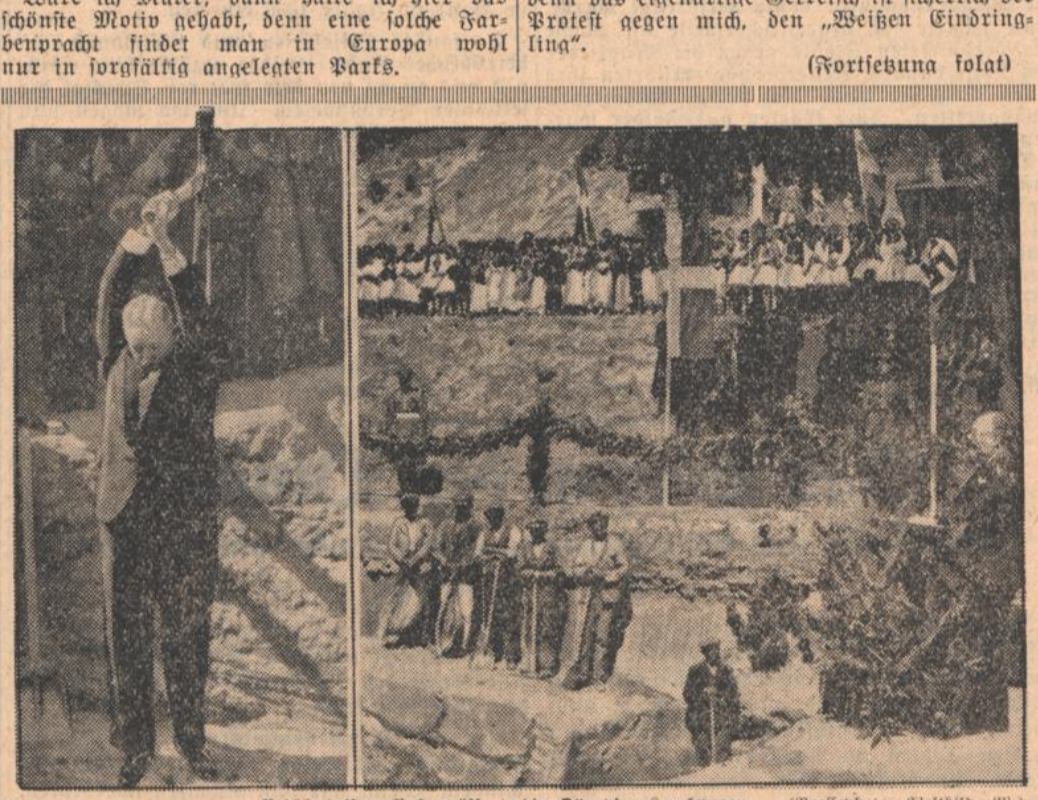
Reichsminister Rust eröffnete die Olympiagründungen (Pressefoto, Weltbild, W.). Im Auftrag des Führers hat Reichsminister Rust die neuen deutschen Ausgrabungen in Olympia eröffnet. Links der Reichsminister bei dem ersten Spatenstich. Rechts der griechische Antikminister Georgakopoulos bei seiner Ansprache bei der Feier in Olympia.
