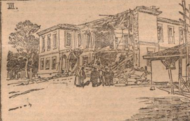
Die beschädigte u. z. unbewohnte frühere Kommandantur von Tschanak Kaleh.
