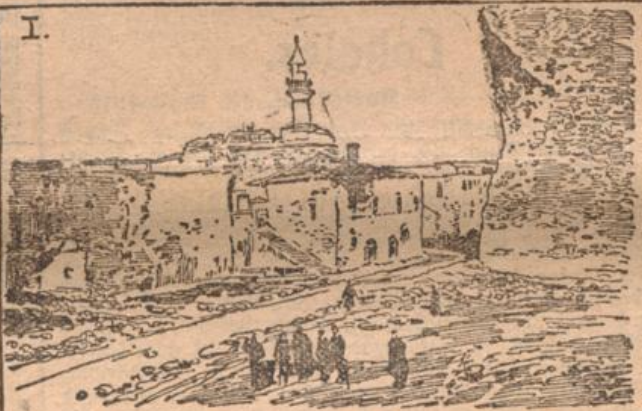
Granatwirkung an einem Nebengebäude innenhalb der Festung Kaleh Sultanieh.
