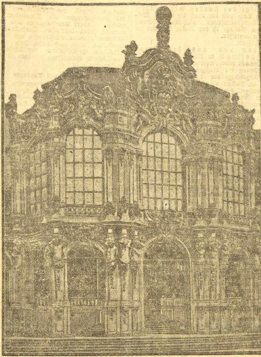
Der Westpavillon des Dresdener Zwingers.
