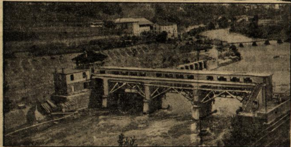
Oben: Das größte Braunkohlekraftwerk der Welt in Golpa-Schornewitz; unten: das größte Wasserkraftwerk Europas in Karbaun (Ober-Italien).
