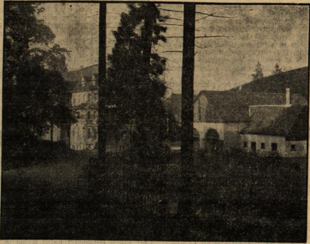
Blick vom Walbesrand auf Haupt- und Nebengebäude
