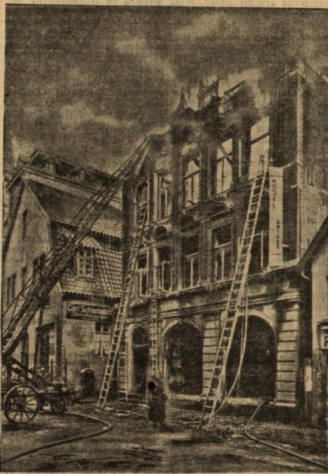
Der Hotelbrand in Detmold
