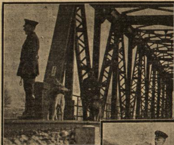
Kosten an der Eisenbahnbrücke Karlsruhe-Durlach.
