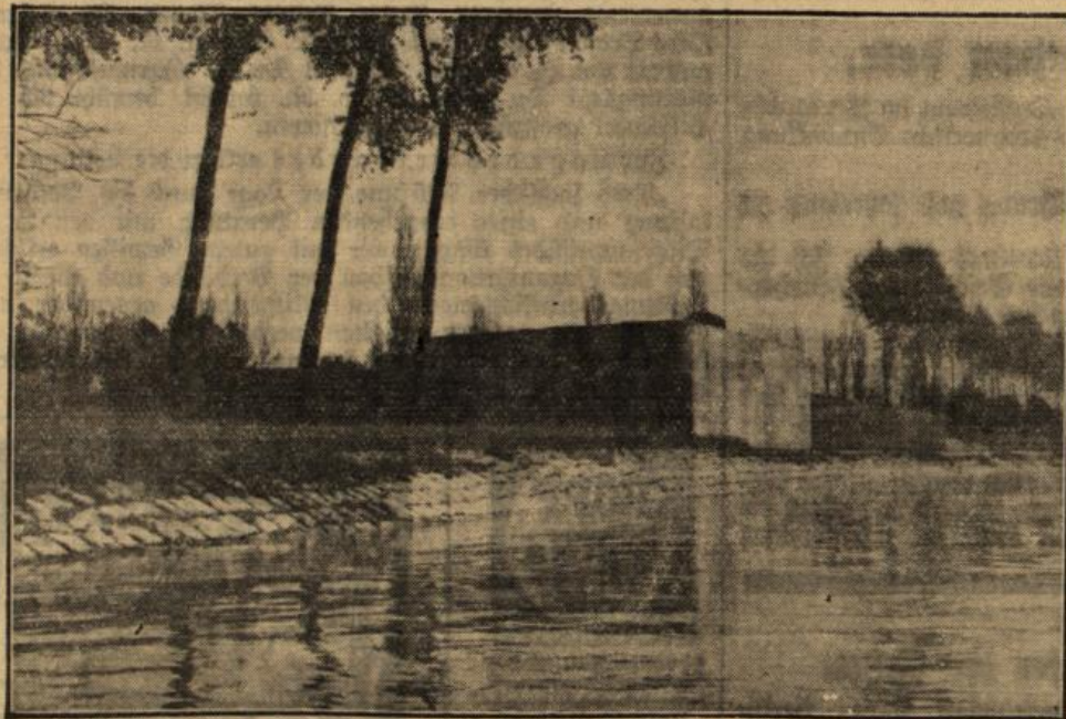
Betonfort mit Panzerkuppel. Schießscharten durch Eisenguss verdeckt.
