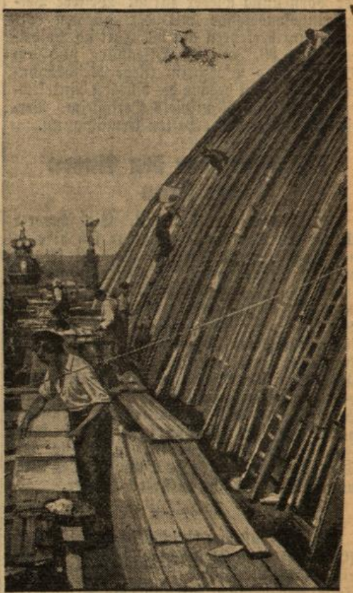
Die Arbeiten an der Reichstagskuppel
