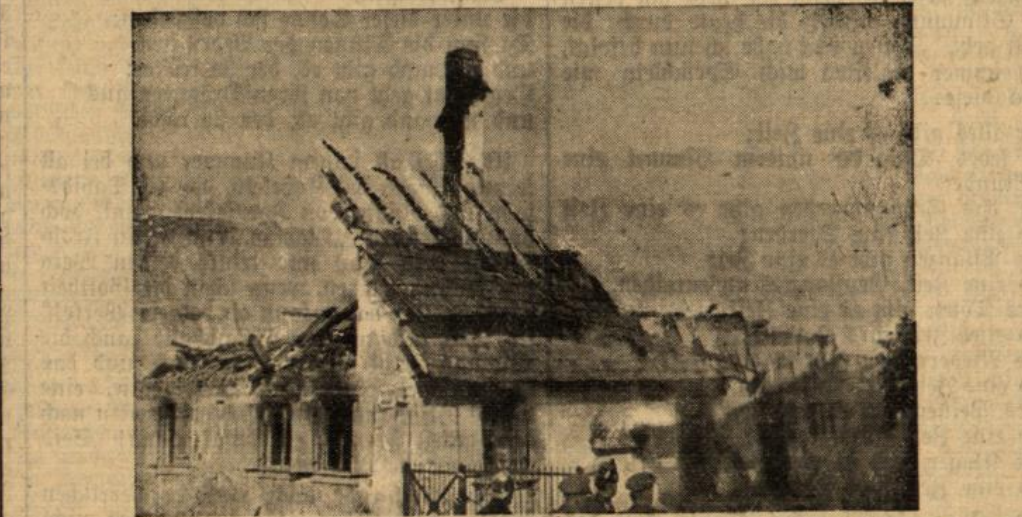
Die Brandstätte in Niederbühl Aufnahme: Gollhütter-Kastell
