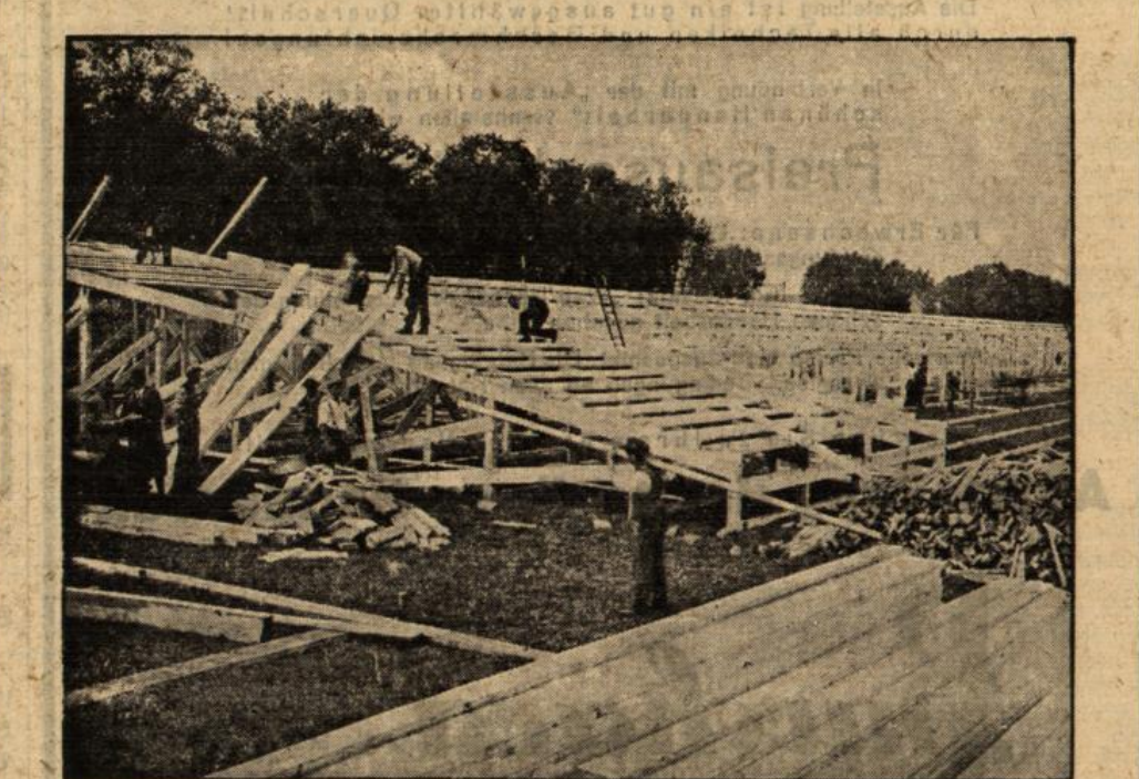
Am Tag und Nacht anhaltender Arbeit wird auf den Karlsruher Rennwiesen, dem Schauplatz des badischen Gau-Appells vom nächsten Sonntag, eine Riesentribüne von 200 Meter Länge und 40 Meter Tiefe errichtet.
