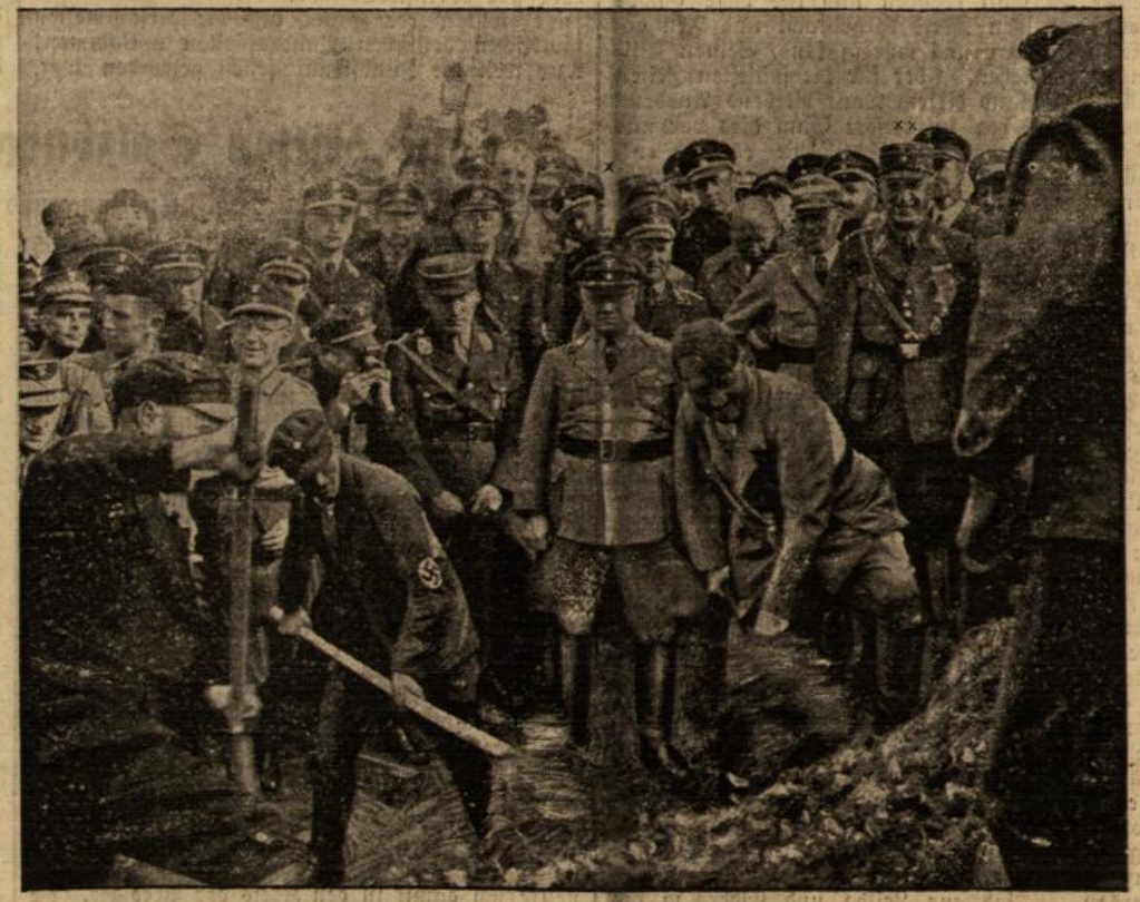
Der feierliche Baubeginn der ersten Reichsautobahn
