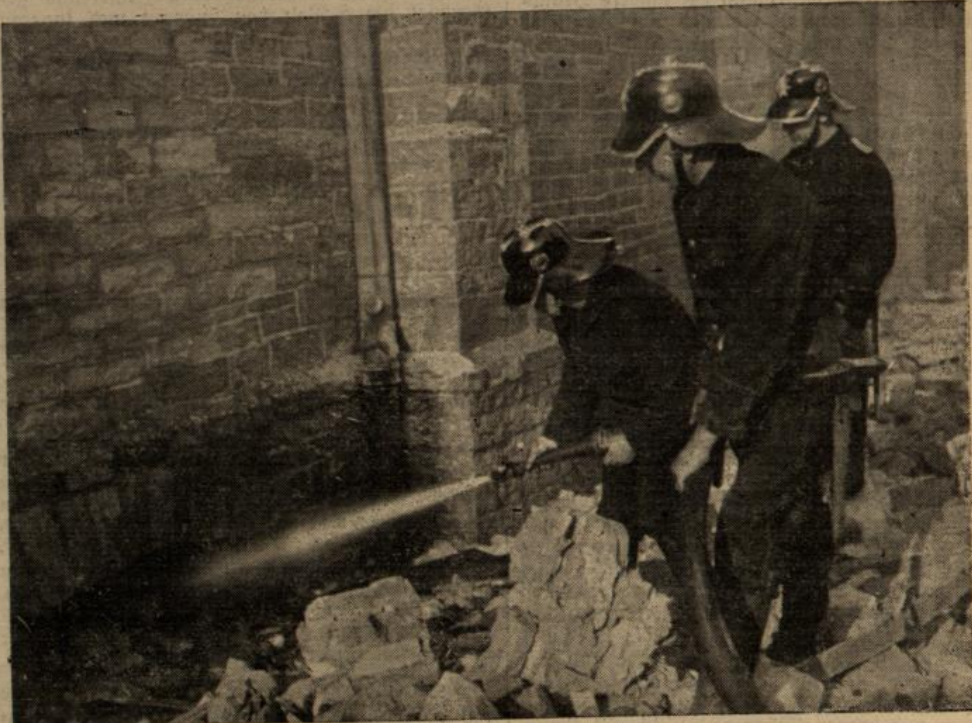
Immer wieder züngeln aus Kellerluken Flammen empor
