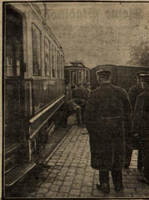
Mit Winden und Hebeln wird die Straßenbahn wieder ins rechte Geleis gebracht.
