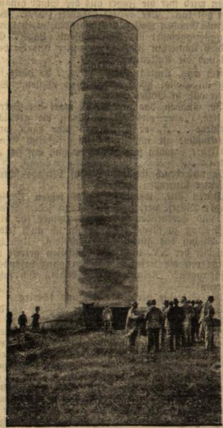
Stromerzeugung durch Flettner-Rotor
