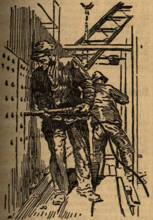
Rieten an der Außenhaut mit Presslufthammer
