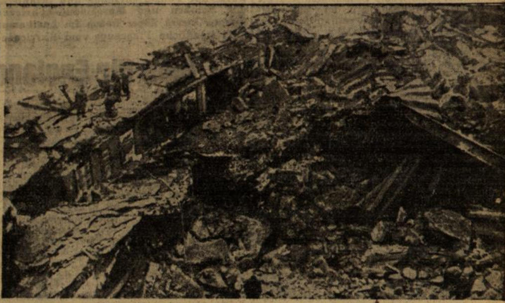
Londoner U-Bahnstation von deutscher Bombe zerstört (Aufnahmen: Presse-Hoffmann)
