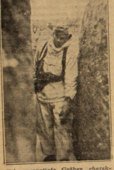
Uebermannstiefe Gräben charakterisieren die in monatelanger Arbeit ausgehobenen Winterstellungen unserer Truppen im Osten. PK.-Aufnahme: Biewend (Sch.)
