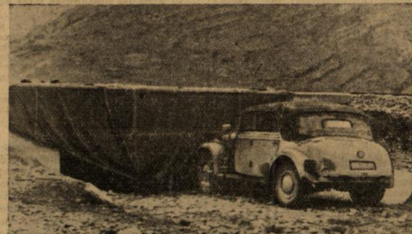
In diesem Durchlaß einer Schmalspurbahn wohnte der Generalfeldmarschall Rommel eine Zeitlang während des Vormarsches an der tunesischen Front. PK.-Aufn.: Hurtmanns-Atlantic
