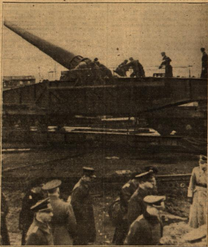
Ausländische Militärattachés besichtigen die Befestigungen an der Kanalbrücke. — In der Feuerstellung einer Eisenbahnbrücke. — PK.-Aufnahme: Schwoon (HH.)
