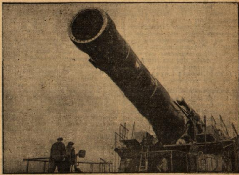
Ein Geschütz der schwersten Artillerie im Aufbau am Atlantikwall. PK.-Aufnahme: Wochenschau (HH.)
