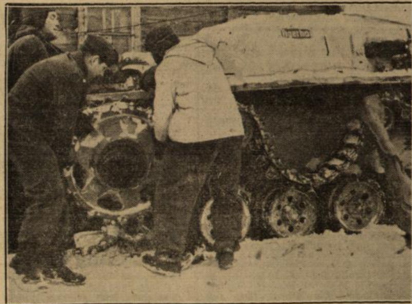
Das Laufband eines Panzers muß ausgewechselt werden. Mit geübter Hand gehen die Monteur ans Werk. PK.-Aufn.: Laßberg-Atlantic
