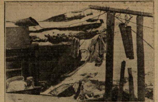
Die seltsamsten Alarminrichtungen kann man an den Bunkern der Grenadiere vor Leningrad kennenlernen. Die Güte der Konstruktion hängt erstens von dem vorhandenen Material ab, zweitens von der technischen Findigkeit der Grenadiere. Diese Alarminrichtung ist vom Posten durch Strippenzug zu bedienen und alarmiert die Gewehrbedienende des Bunkers.
