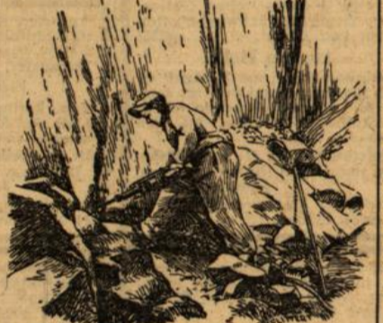
Preßluftbohrhämmer fressen sich ins Gestein. Zeichnungen: Flittert
