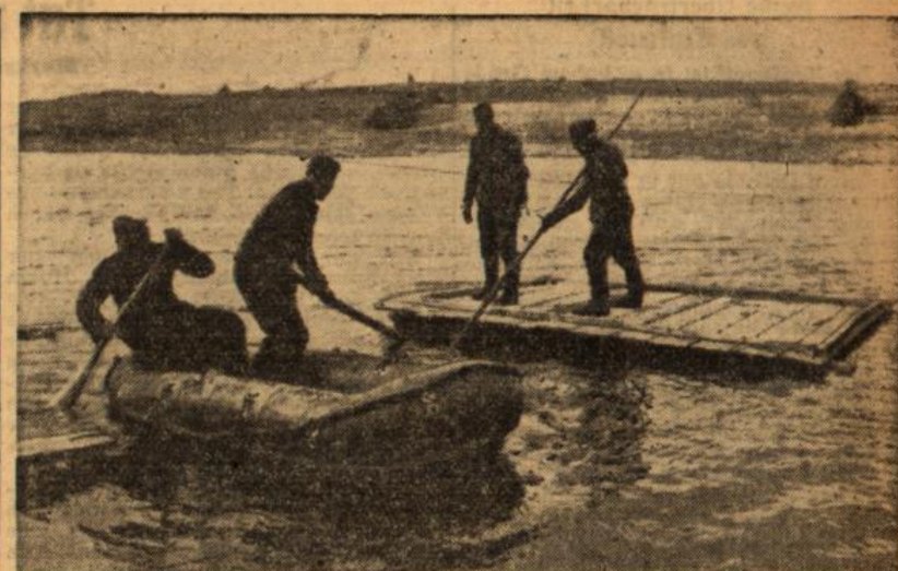
Brückenkopf B. weiter ausgebaut und gesichert! Schon schwimmt das Floß im Wasser. Der Zugführer unternimmt die Fahrt und bald ist die Fähre bei den Kameraden drüben am Brückenkopf gelandet.
