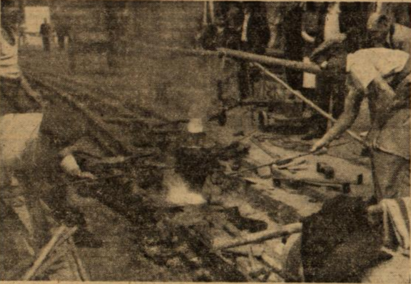
Rauchend schießt das feuerflüssige Eisen aus dem Schmelztiegel in die Gießform. (Zeichnungen: Schweizer, Aufnahmen: Amann)
