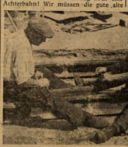
...und hier wird gehobelt.
