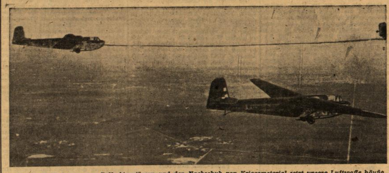
Für die Beförderung von Fallschirmjägern und den Nachschub von Kriegsmaterial setzt unsere Luftwaffe häufig Lastensegler ein, die von Motorflugzeugen bis in die Höhe des Ziels geschleppt werden, um dann, nachdem das Schleppseil ausgeklinkt ist, selbständig den Rest der Flugstrecke segelnd zurückzulegen. — Lastensegler mit Fallschirmjägern an Bord, kurz vor dem Ziel. Bald wird das schleppende Motorflugzeug das Drahtseil ausklinken und zu seinem Ausgangshafen zurückkehren. (PK.-Aufnahme: Seeger (Sch.))
